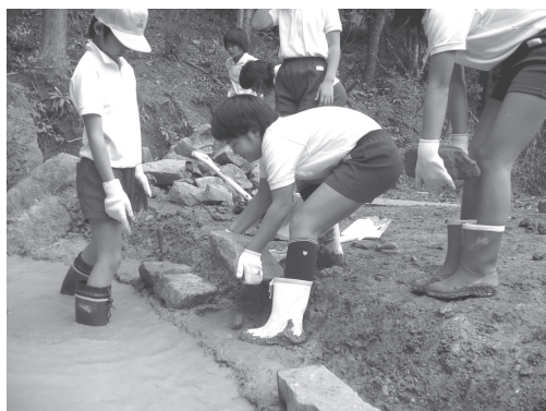
●写真 6 / 難航した石垣積み
